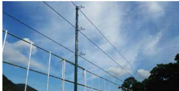
グラスファイバーポールとピッククリップ、ステンレス製ツイストワイヤーを組み合わせた猿対策用の電気柵です。
